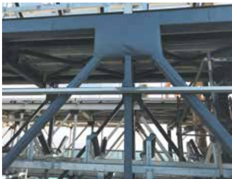
Огнезащита металлоконструкций в условиях морского климата сеткой «ПРОМИЗОЛ СТК-Мет»
