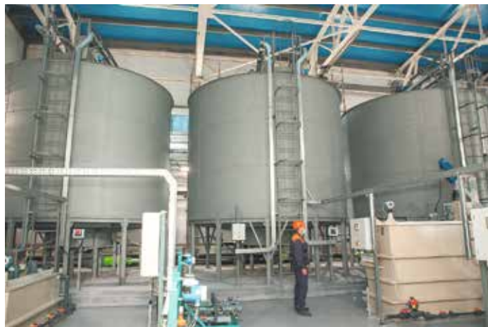
Очистные сооружения ливневого стока Северного промышленного узла и части Центрального р-на г. о. Тольятти. 2020 год
