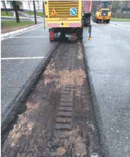
Ремонт дорог силами ООО «УМПРЭО»
