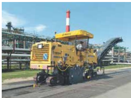
Ремонт и обслуживание дорог ПАО «Славнефть-ЯНОС»
