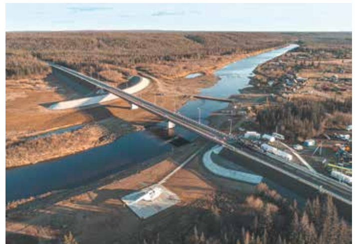
Мост через реку Малая Ботуобуя. Автодорога «Вилюй»
