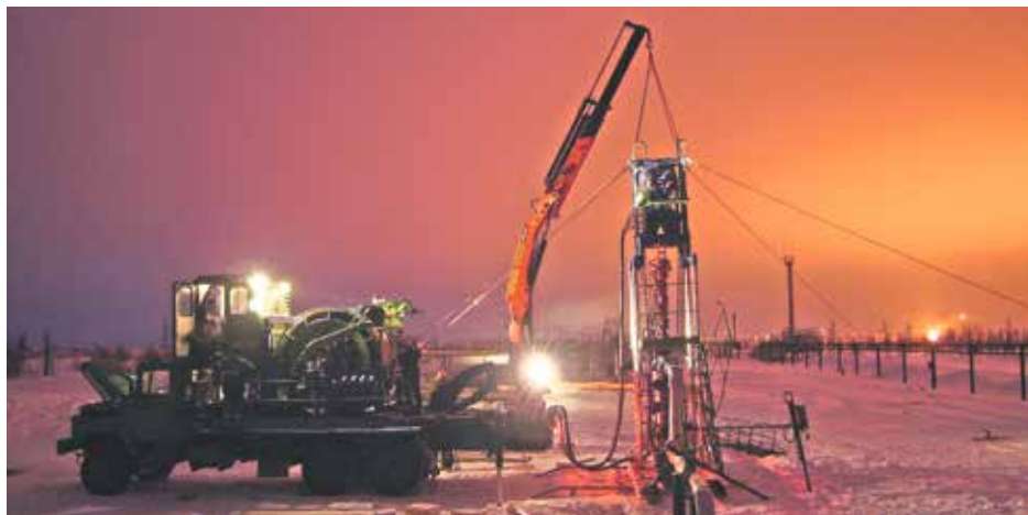
Ремонтные работы на скважине
