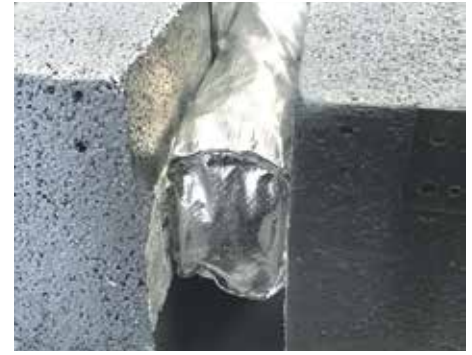
Огнезащитный шнур «ПРОМИЗОЛ-Шов» для деформационных швов до 150 мм
